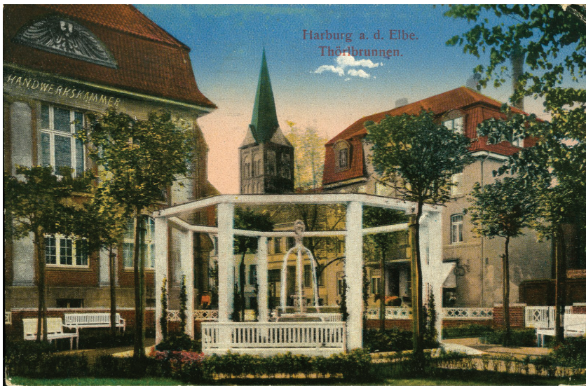
Der Thörlbrunnen vor der alten Handwerkskammer, um 1910. Foto: © AMH
